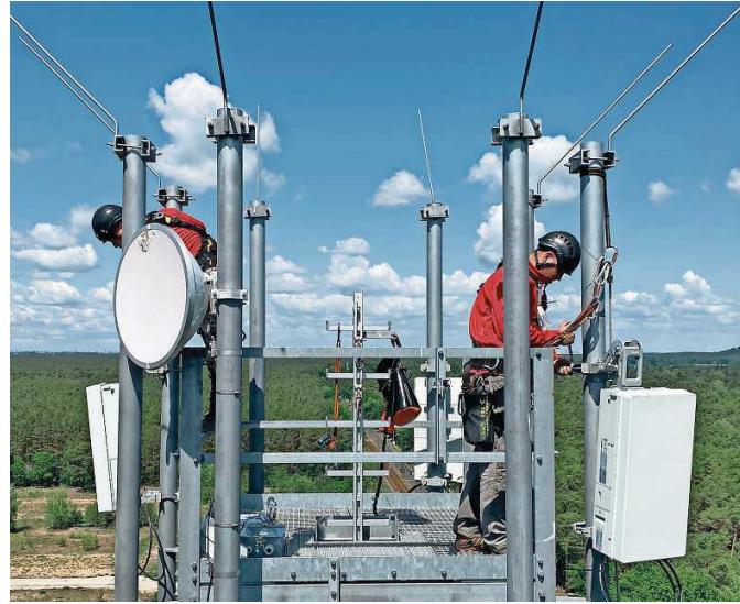
Arbeiter montieren Antennen für die fünfte Mobilfunkgeneration.
